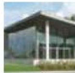
Site Desselgem INSULATION
